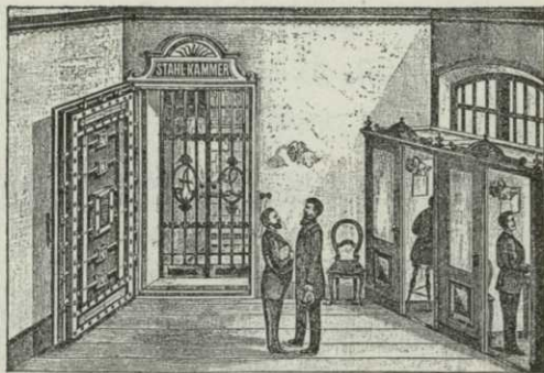
Vorraum zur Stahlkammer.
