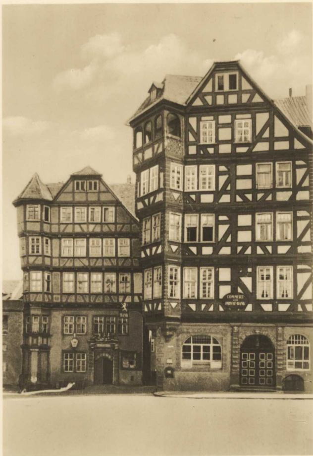
Alt-Kassel. Mittelalterliche Fachwerkbauten am Altmarkt.
