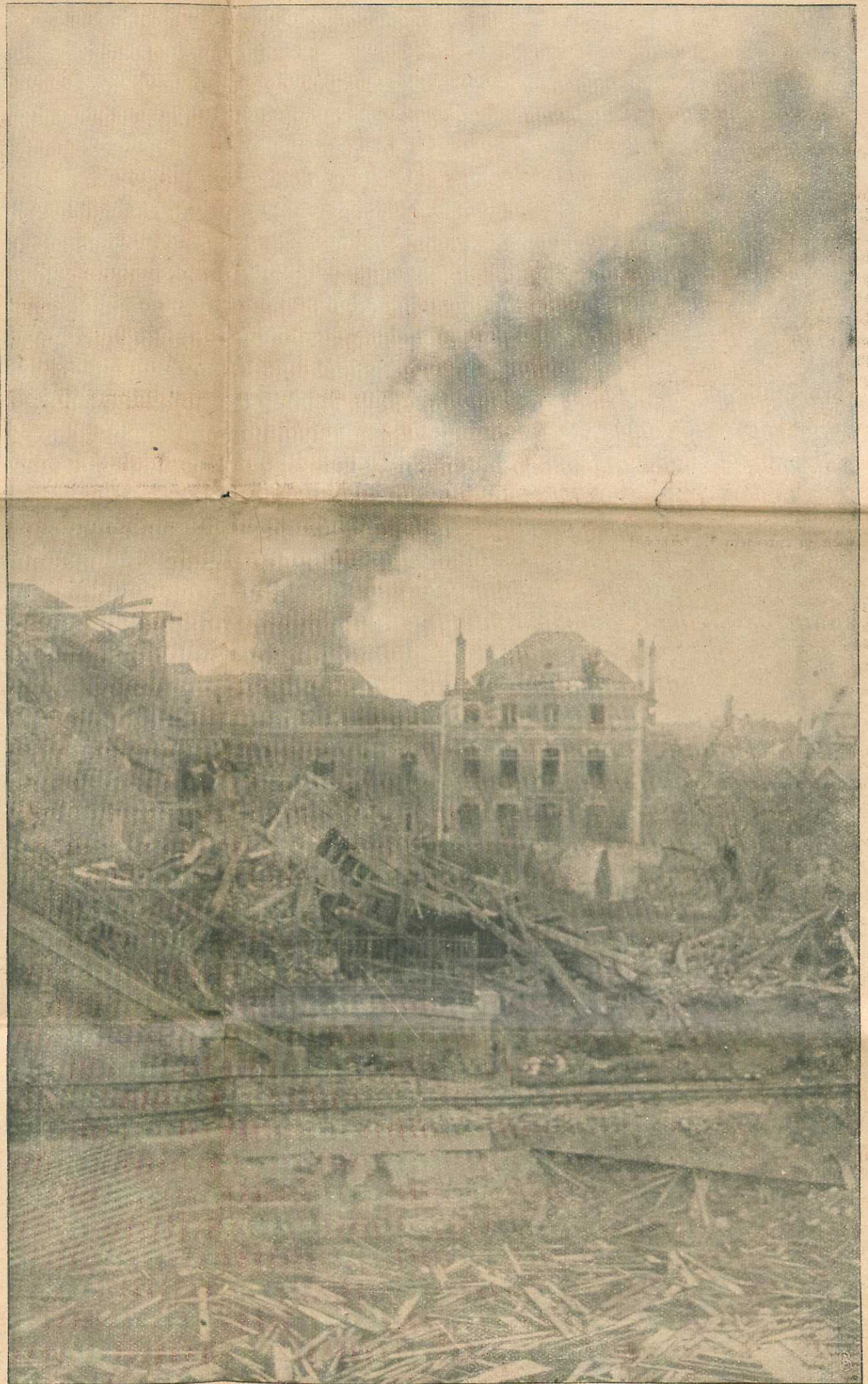
Französische Vernichtungswut: Die zerstörte Brücke von St.-Quentin.
