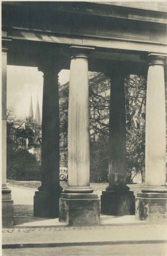
Kassel. Durchblick vom Äuetoer auf Regierungsgebäude und St. Martinstürme
