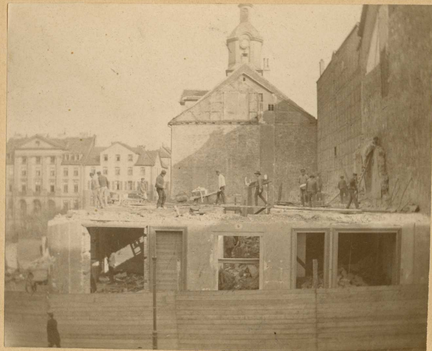
Abbruch des Koppelschen Hauses, Ob. Königsstr. 6
