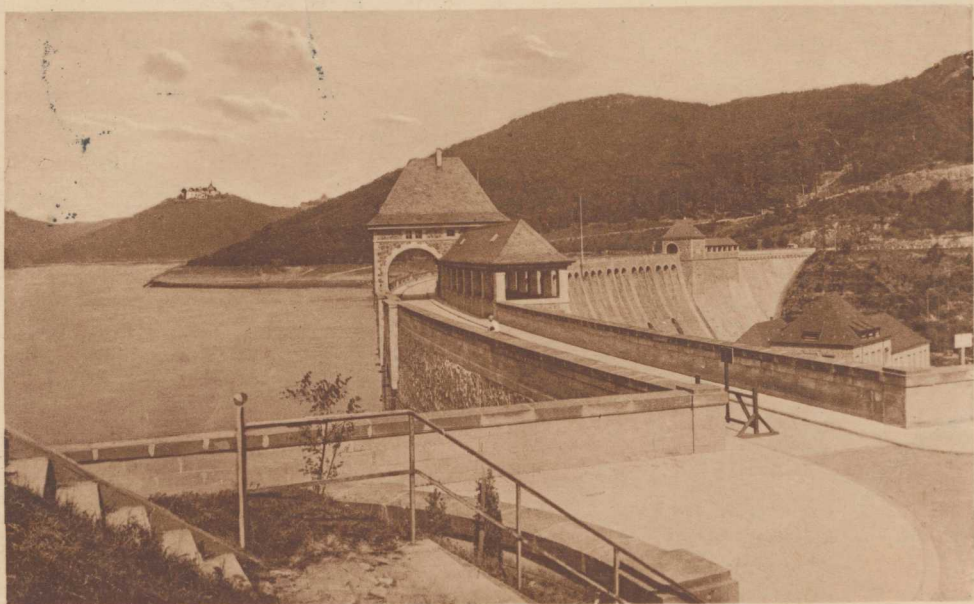
Die Edertalsperre, Aufgang zur Sperrmauer mit Stausee und Schloß Waldeck
