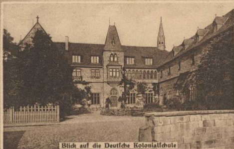
Blick auf die Deutsche Kolonialschule
